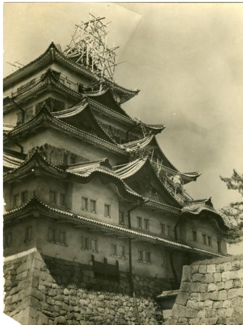
(古写真「金シャチを下 ための足場を組む」)
